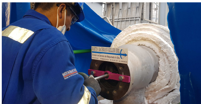
Fuente: 20220530_080720 Proceso de rectificado
